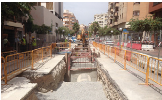
Foto 17: Nuevo colector Ø1000 en c/ Devesa.
