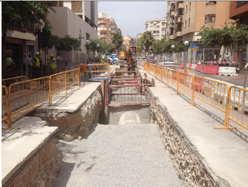
Foto 17: Nuevo colector Ø1000 en c/ Devesa.
