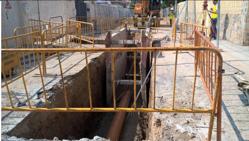
Foto 18: Nuevo colector Ø315 en Urbanización Bellavista.
