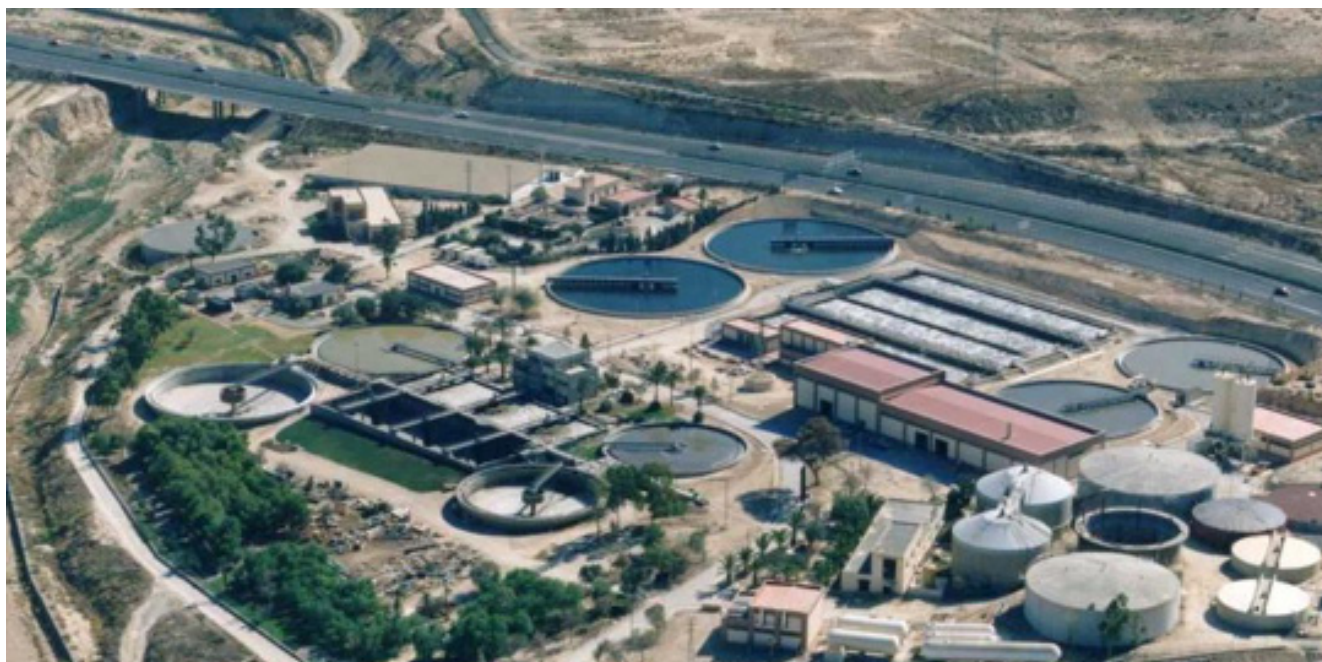
EDAR Rincón de León. Vista aérea.
