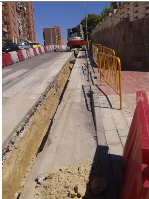
Foto 13: Canalización en calle Las Redes.
