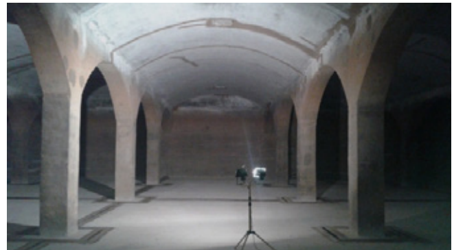
Foto 14: Sellado de juntas en el interior del depósito de Cabo Huertas.
