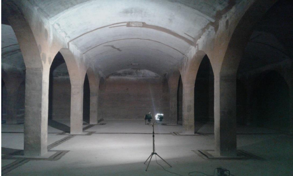
Foto 14: Sellado de juntas en el interior del depósito de Cabo Huertas.
