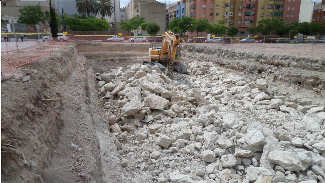
Foto 19: Excavación para ejecución depósito agua reutilizada.
