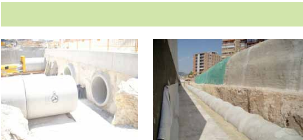
Foto 8: Reposición de infraestructuras obras entrada AVE en Alicante.
