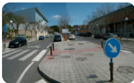
Foto 2: Estación bombeo Monte Tossal
