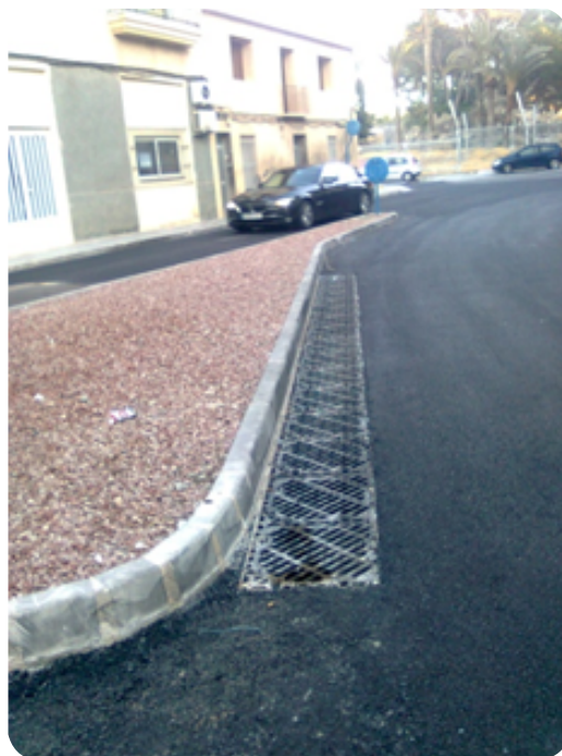
Foto 8: Captación Colector Villafranqueza Fase II
