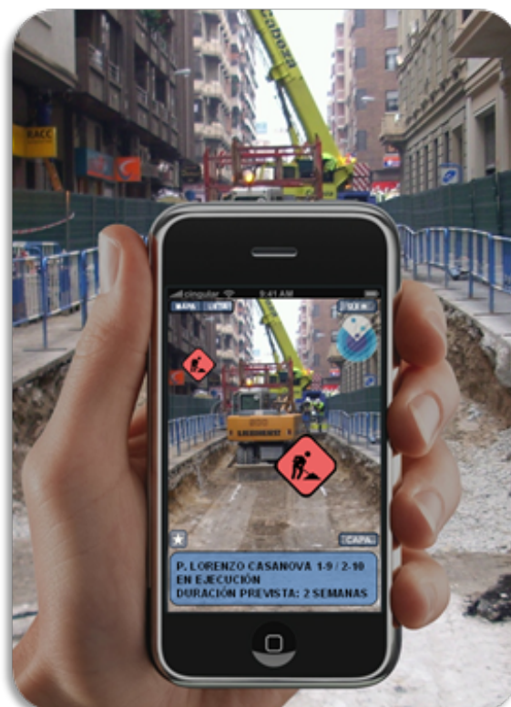
Aplicación de Realidad Aumentada para comunicación y seguimiento de obras
