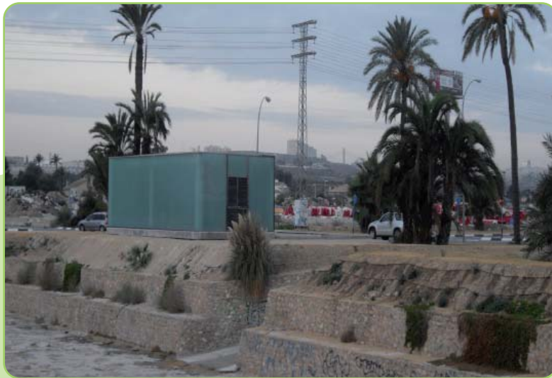
Foto 3. Estación de Bombeo barrancos de Orgegia y Juncaret.
