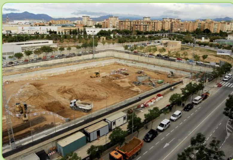
Foto 4. Vista aérea de la construcción del depósito.
